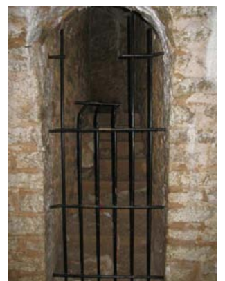
Photo CPNCA : Grille dégradée
